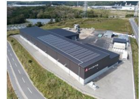
(株)アドベル小山マテリアル リサイクルセンター
