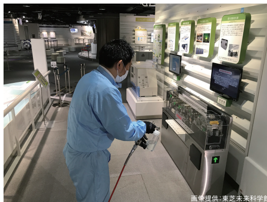
無光触媒コーティング施工の様子。
